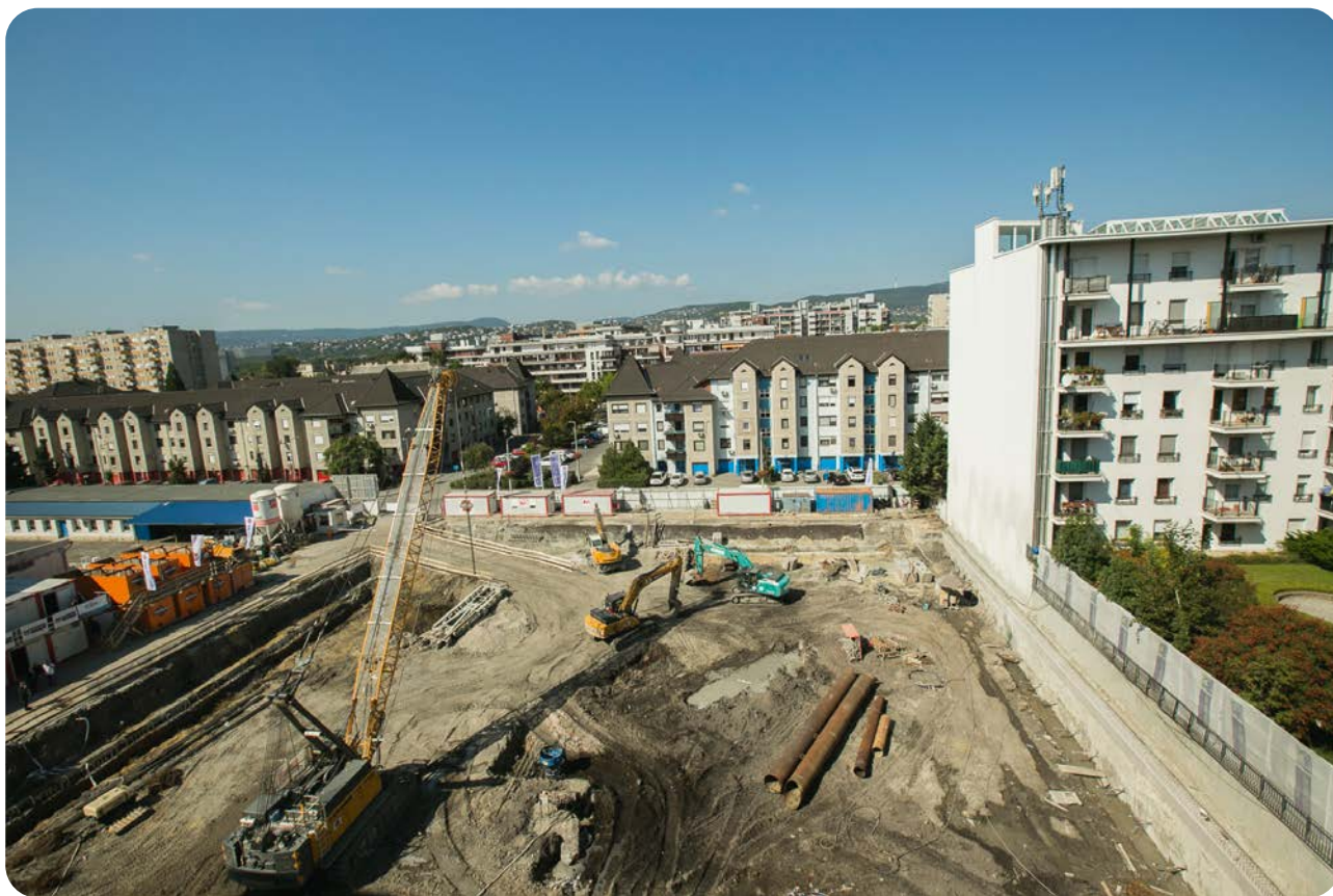
Zajlanak az épülő Visegrádi utcai műszaki épületszárny talajmunkái 2020 szeptemberében
