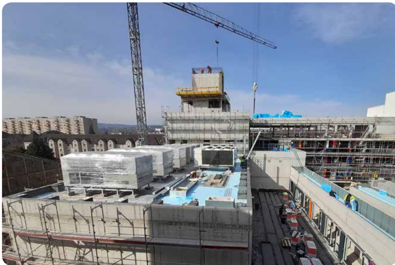
A többfunkciós műszaki épület építése a hatóság Visegrádi utcai telephelyén
